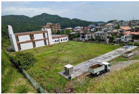
高麗汚水処理施設
